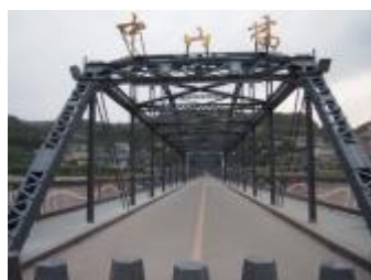
黄河に初めて架られた鉄の橋（中山橋）
